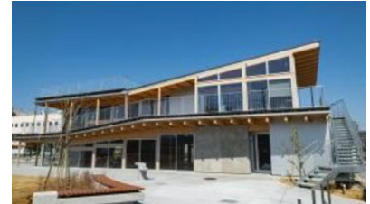
寄居駅南口駅前拠点施設
