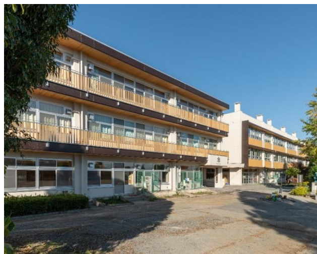
工事完了後の男衾中学校（校舎外観）
